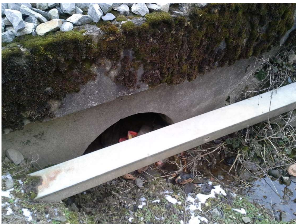
Foto 4: Propustek zanesený náplavami
