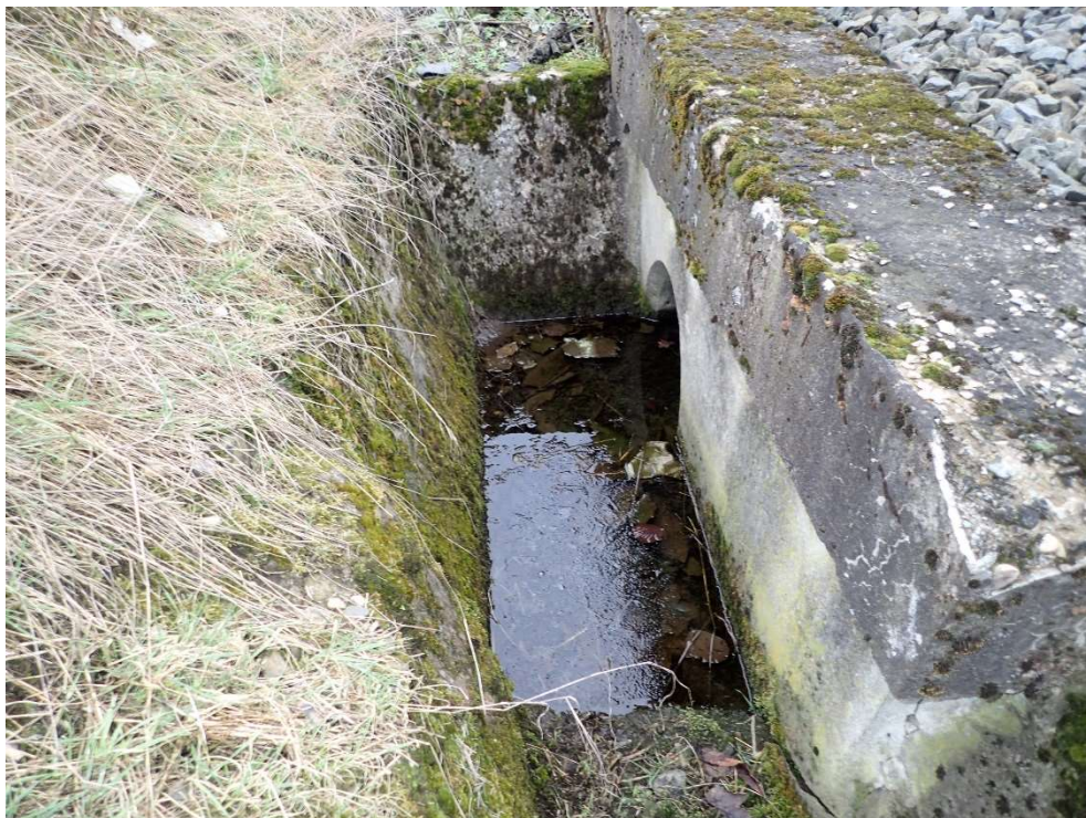
Foto 3: Zanesený propustek, zvětralý beton říms
